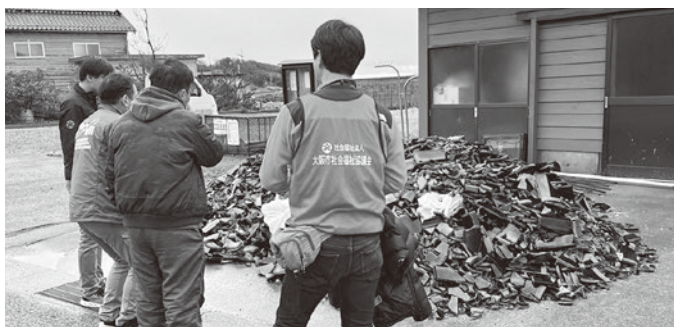
▲現地調査の様子（2月6日）
