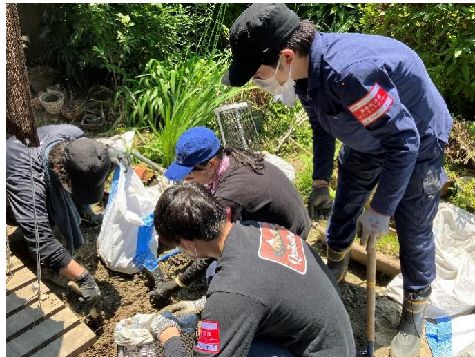
▲泥出しやがれき撤去などの作業をおこないました。被災者の方との関わりをとおして、被災者の想いに寄り添って活動することが大切だと感じました
